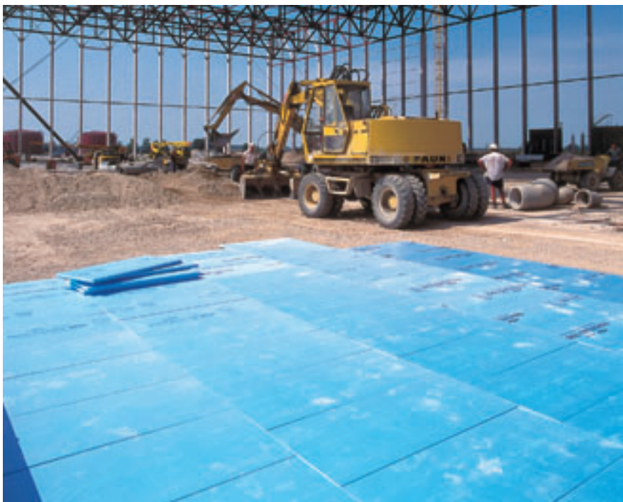
Letiště v Mnichově, tepelná izolace podlahy v hangáru
