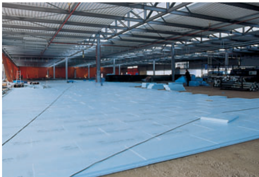
Tepelně izolační desky FLOORMATE se pokládají provázaně
